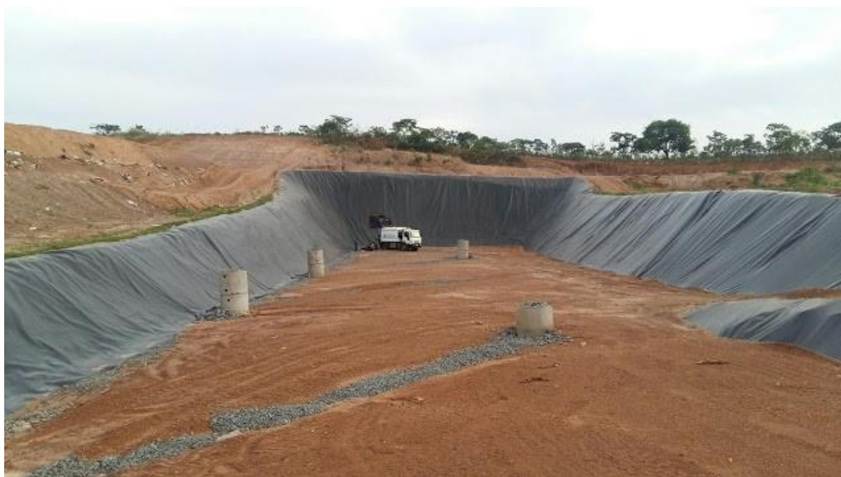
Figura 1-Aterro de Hidrolândia (Goiás) do tipo trincheira
