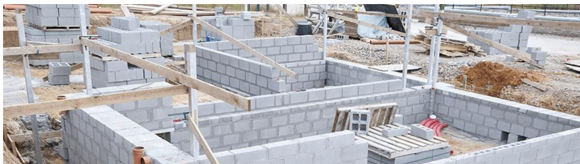
Figura 2. Construção com Bloco de concreto.
