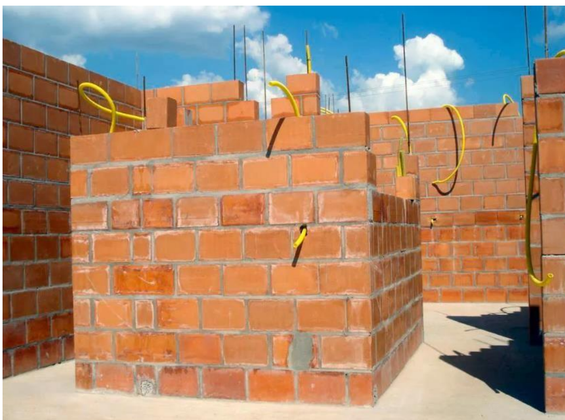
Figura 8. Construção com bloco cerâmico
