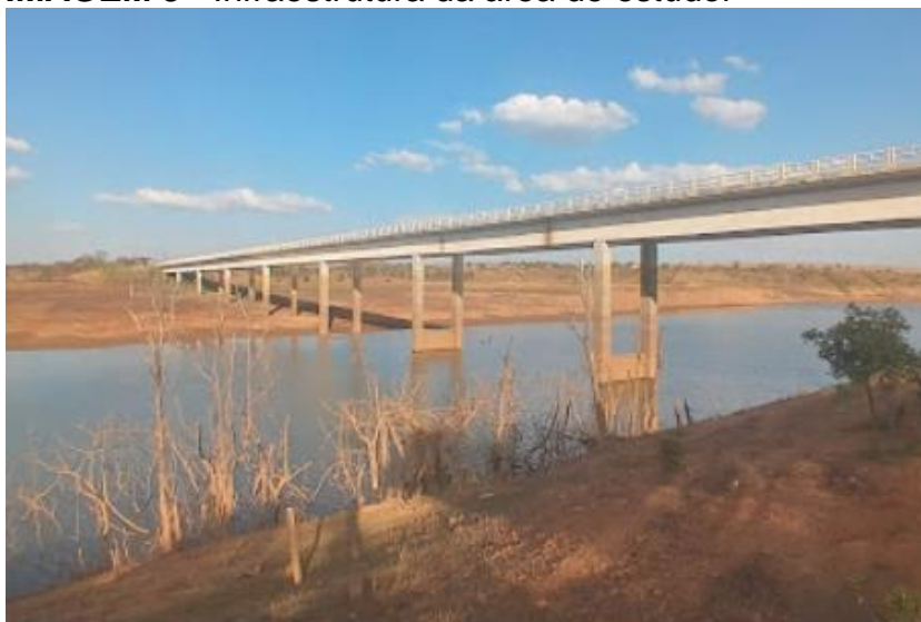
IMAGEM 3 - Infraestrutura da área de estudo.
