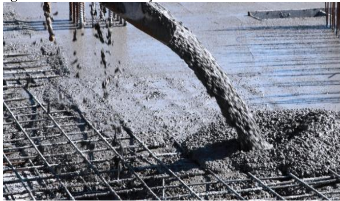
Figura 1 – Armaduras de aço recebendo o concreto ainda fluido.
