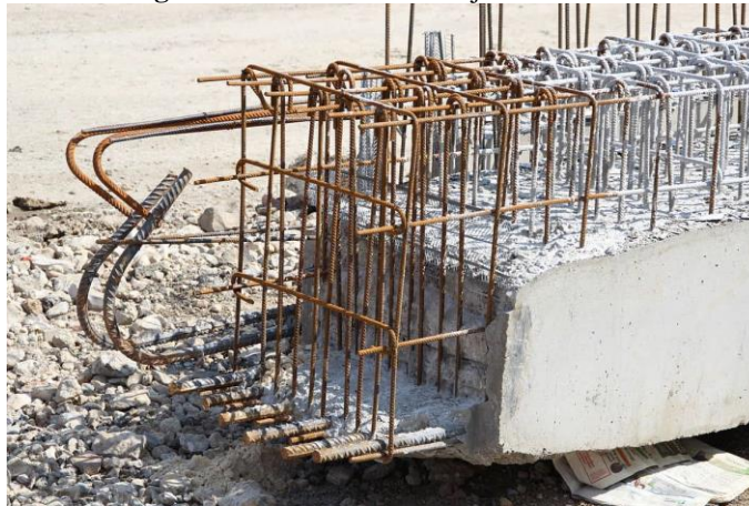
Figura 2 - Concreto armado já endurecido.
