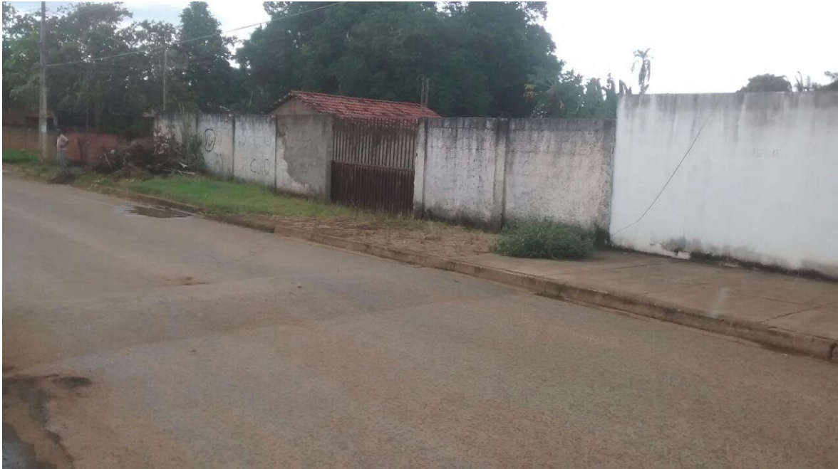
Figura 13: Muro da frente do lote
