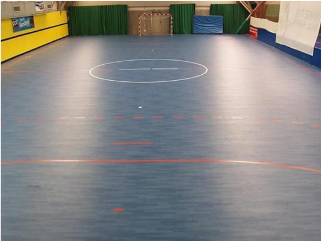
Figura 9: Quadra em piso vinílico esportivo
