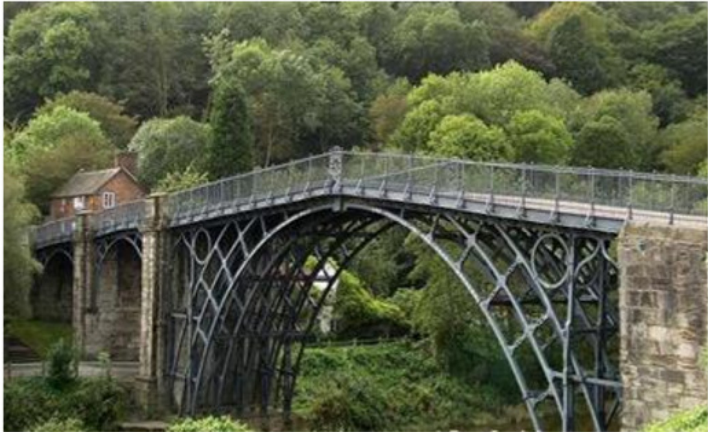
Figura 2 - Ponte sobre o Rio Severn, Inglaterra – 1779 Fonte: As primeiras construções em ferro fundido e forjado.
