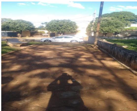
Figura 11 – inclinação da rampa de acesso
