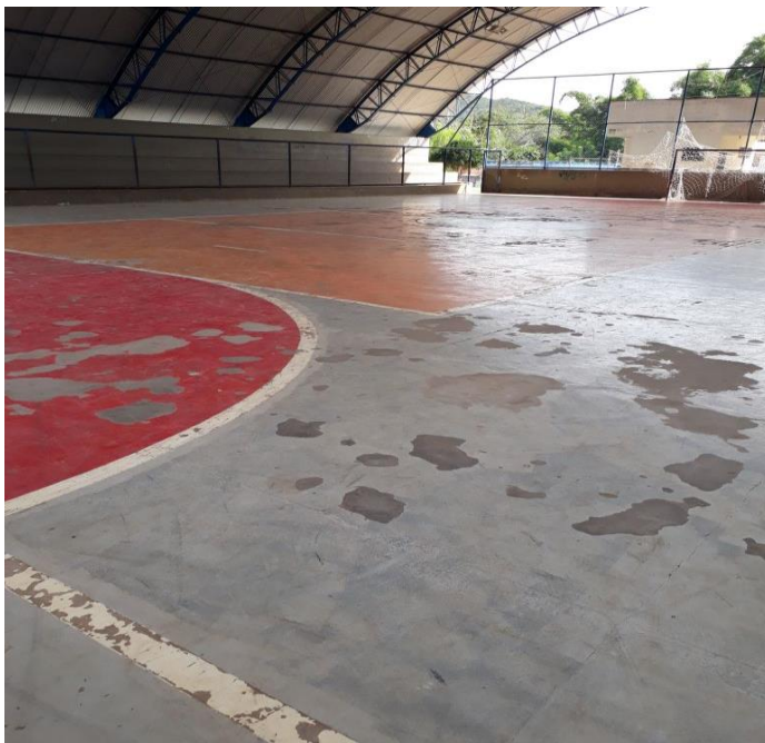
Figura 4: Piso da Quadra
